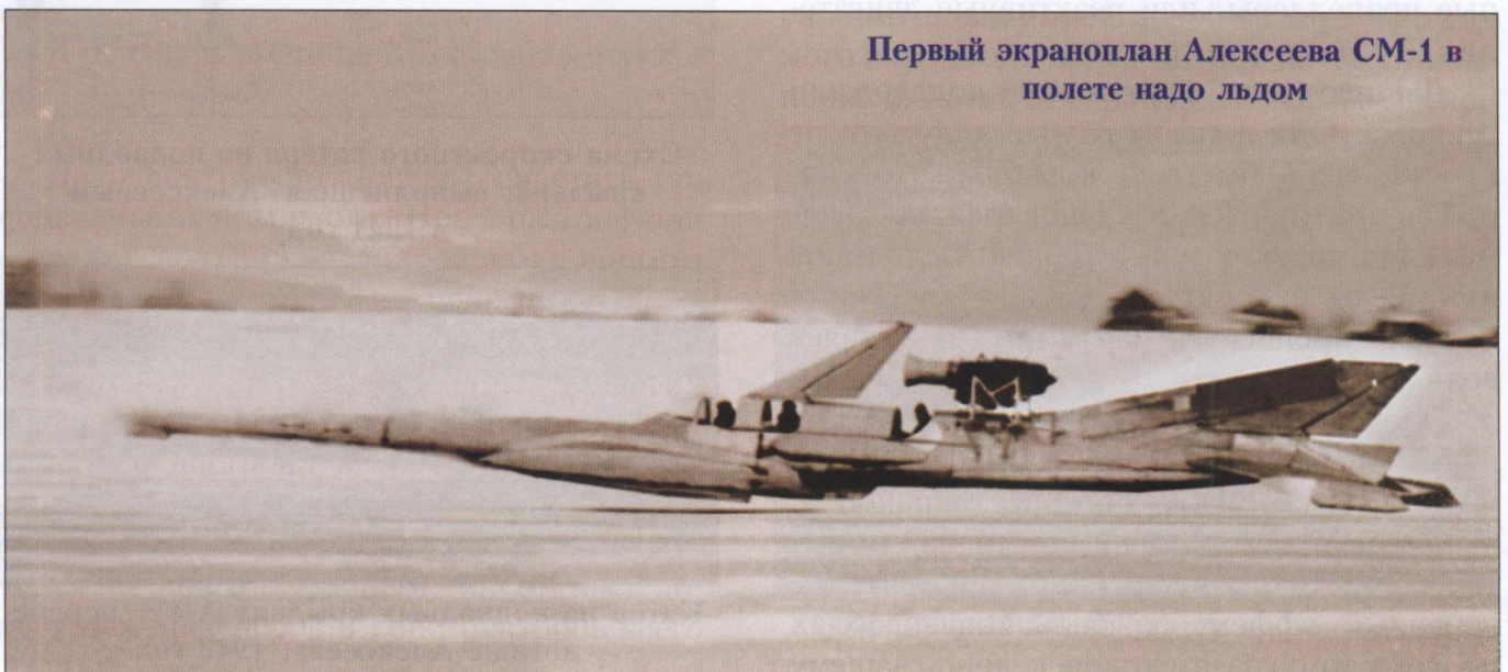
Схема экраноплана СМ-1. Обратите внимание на короткое и широкое крыло — фирменный почерк Алексеева
